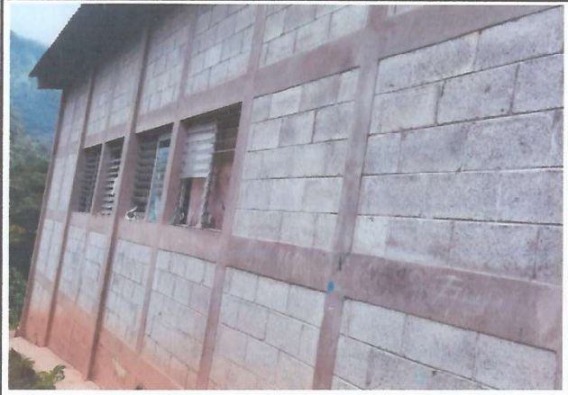
Foto 2: MEJORAMIENTO DE VENTANAS Y BALCONES LATERALES
