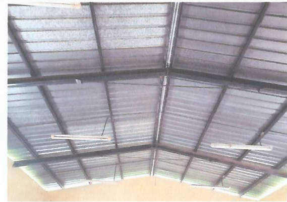
Foto 3: MEJORAMIENTO DE ESTRUCTURA DE TECHO Y CUBIERTA DE LÁMINA TROQUELADA CALIBRE NO.26
