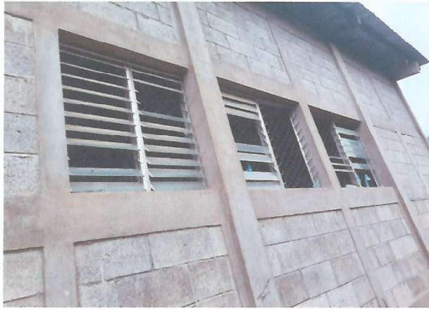
Foto1: MEJORAMIENTO DE VENTANAS Y BALCONES LATERALES
